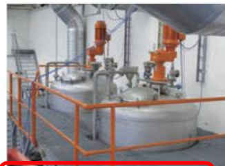
图3-32 工业化合成使用的反应釜
